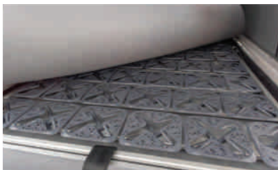
Komfortables Dachbett mit Froli-System
